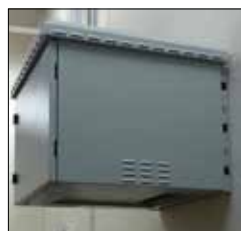
falraszerelés függőleges tartósínnel
